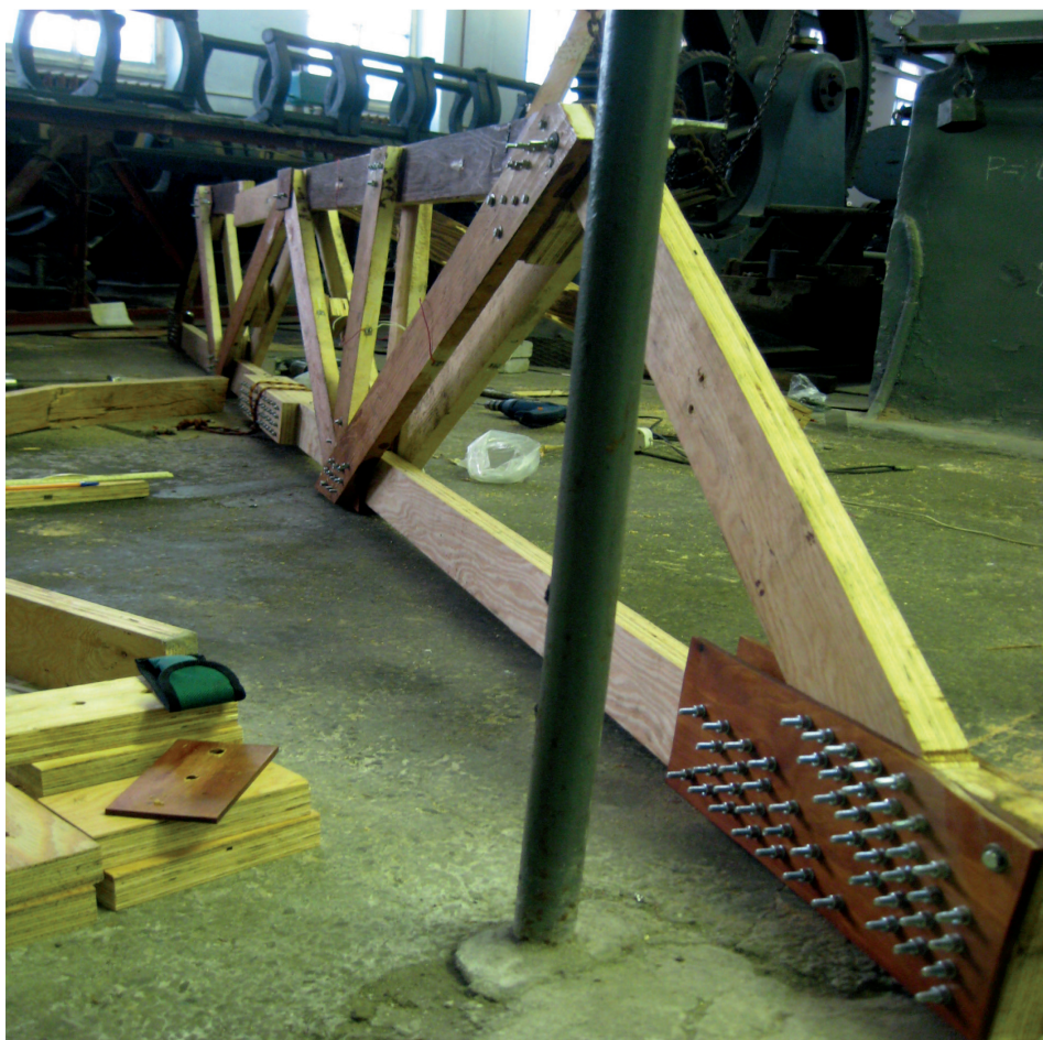
Рис. 58. Готовая конструкция в сборе
