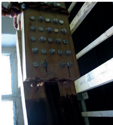
Рис. 67. Разрушение конструкции в накладках нижнего пояса от скальвания
