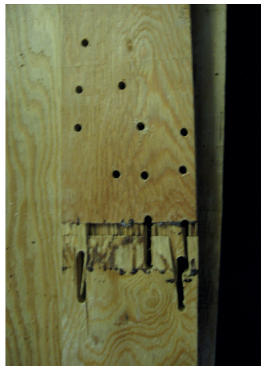
Рис. 67. Разрушение конструкции в накладках нижнего пояса от скальвания
